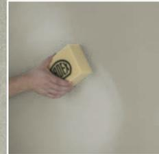
3. Nach einer Stunde wird die Fläche mit einem Schwamm oder Schwambrett mit Wasser aufgerieben.
