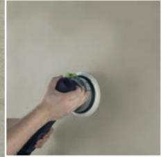
5. Nach ca. 4 – 5 Stunden wird die Oberfläche mit einem Exzenterschleifer und 120er Schleifpapier poliert.
