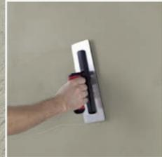
2. Die Oberfläche wird mit einer alten Glättkelle strukturiert.
