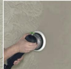
3. Nach ca. 4–5 Stunden werden die Spitzen mit einem Exzenterschleifer und 80er Schleifpapier gebrochen.
