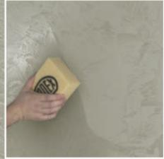
5. Im Anschluss wird das PANDOMO® SP-SL Steinöl dünn aufgetragen und überschüssiges Öl mit einem fusselfreien Lappen abgerieben.
