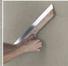
2. Die Oberfläche wird mit einem Flächen-Rakel abgeglättet und strukturiert.
