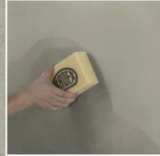
6. Im Anschluss wird das PANDOMO® SP-SL Steinöl dünn aufgetragen und überschüssiges Öl mit einem fusselfreien Lappen abgerieben.
