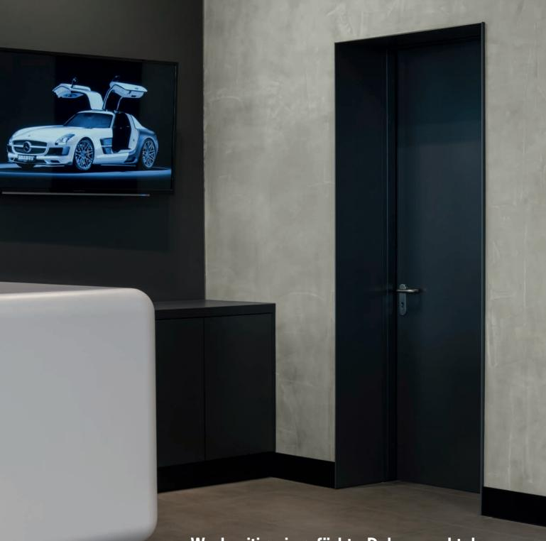
Werkseitig eingefärbte Dekorspachtelmasse im Farbton Betongrau 17/3.1 pre-coloured decorative finishing render of the shade concrete grey 17/3.1
